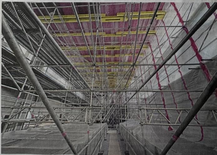
Ein Stahlschun- gel steht im Kirchenschiff, rot zu erkennen ist die Zwischendecke in zehn Metern Höhe. Allein dieser Aufbau hat Wochen gedauert. Zur Orientierung: Das Bild zeigt die Perspektive vom hinteren Eingang der Kirche in Richtung Altarraum.
