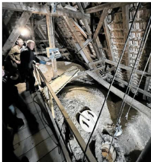
Küster Jacob Hinkel testet die Vorrichtung auf dem Dachboden, mit der der Leuchter gehoben und gesenkt werden kann.
