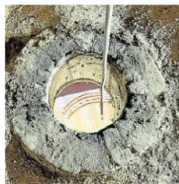
Durch dieses Loch in der Decke verläuft das Stahlseil, an dem der rund 70 Kilogramm schwere Leuchter aufgehängt ist.
