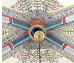
Der Schlussstein verschließt das Loch in der 16 Meter hohen Kuppeldecke.
